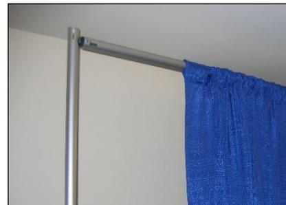
Voici ce qui arrive lorsque les poteaux sont montés et démontés en oblique. L'ouverture se déchire et les poteaux doivent éventuellement être remplacés.
